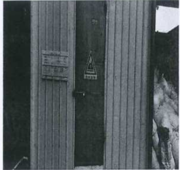
图 4-9 危废房外部图
