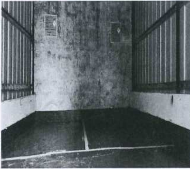
图 4-9 危废房内部图
