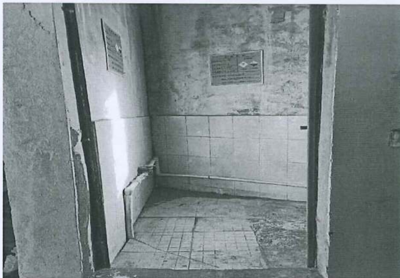
图 4.5 危废房内部图
