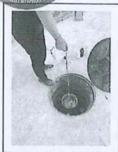
生活污水排放口
