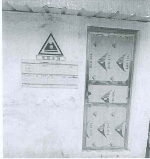
图 4.4 危废房外部图
