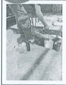
生活污水排放口
