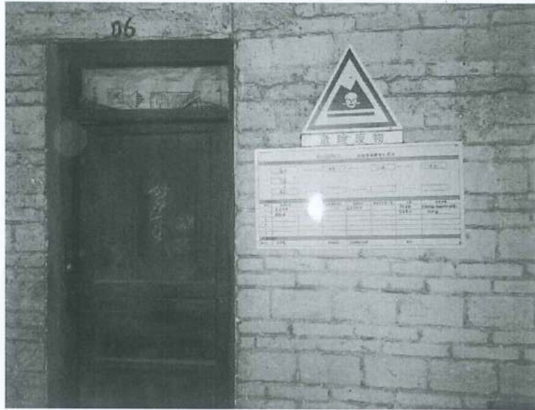
图 4.5 危废房外部图
