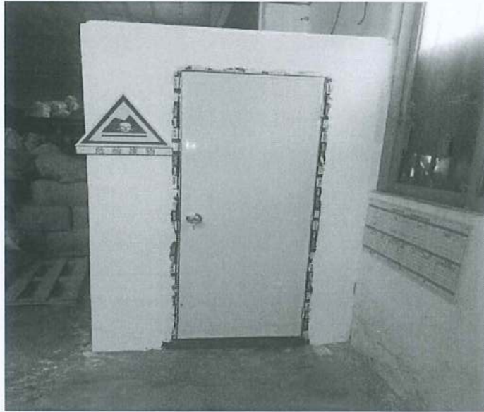
图 4.3 危废房外部图
