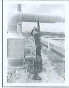
挤出工序废气处理前
