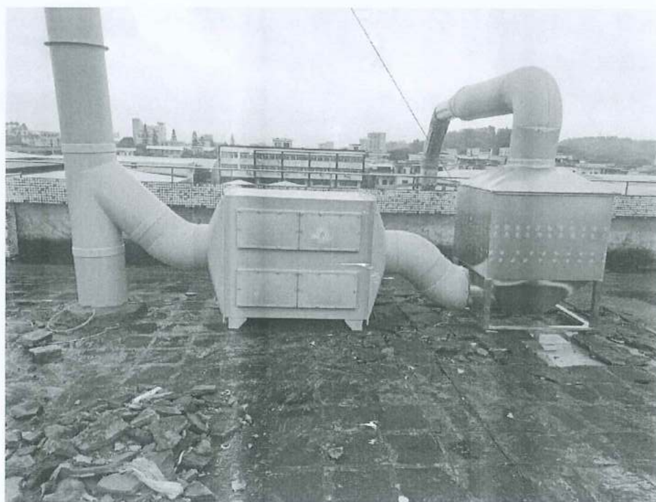
图 4.2 挤出工序废气治理设施现场图
