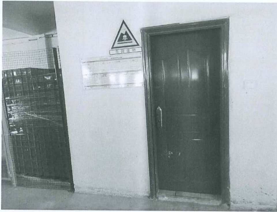
图 4.3 危废房外部图
