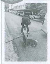
生活污水排放口
