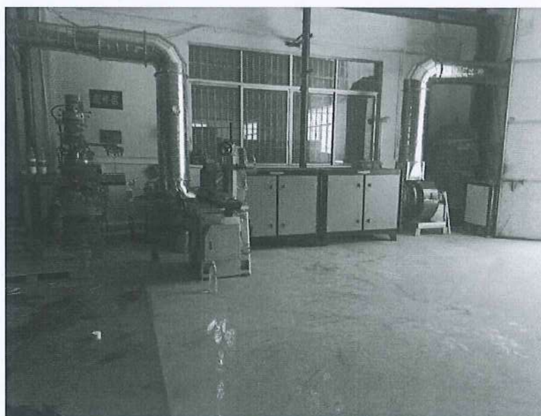
图 4.2 注塑废气治理设施图
