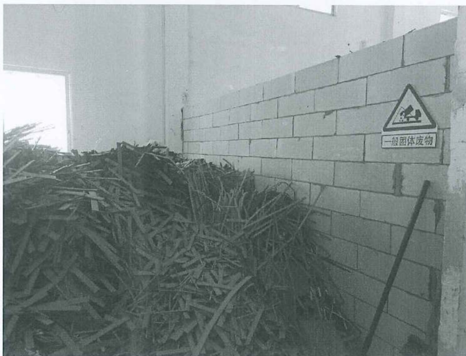
图 4-2 一般固废间现场图
