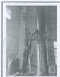
注塑挤出、吹塑废气排放口
