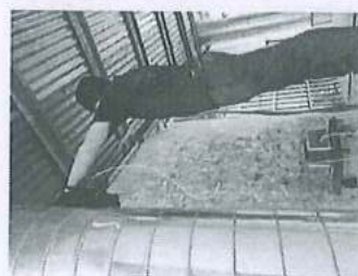
吹膜有机废气处理前检测口/Q1
