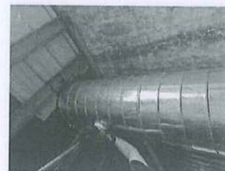
吹膜有机废气处理后检测口/Q2
