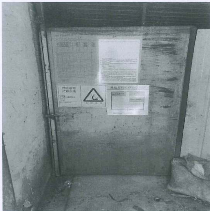
图 4-3 危废房外部图
