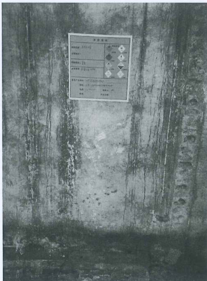
图 4-4 危废房内部图
