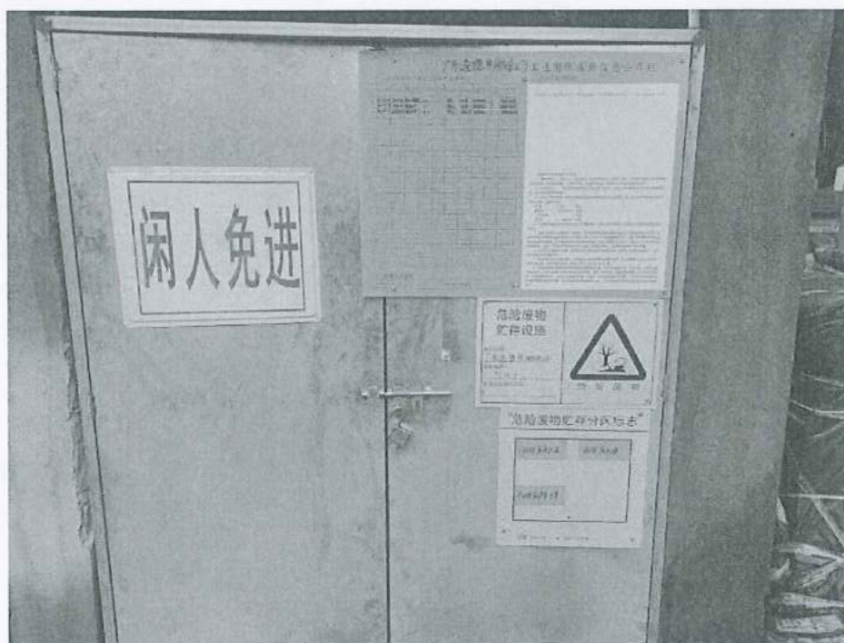
图 4-3 危废房外部图
