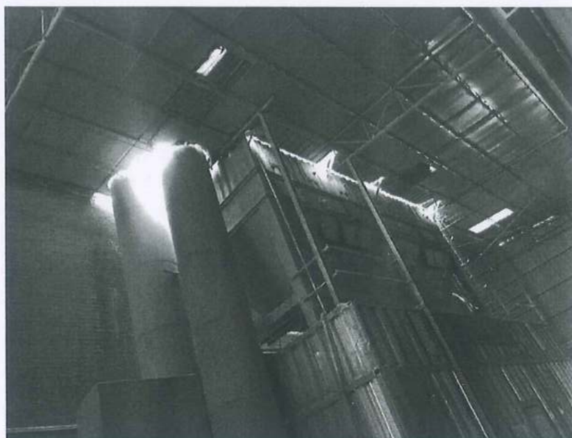
图 4.2 木制加工粉尘治理设施图
