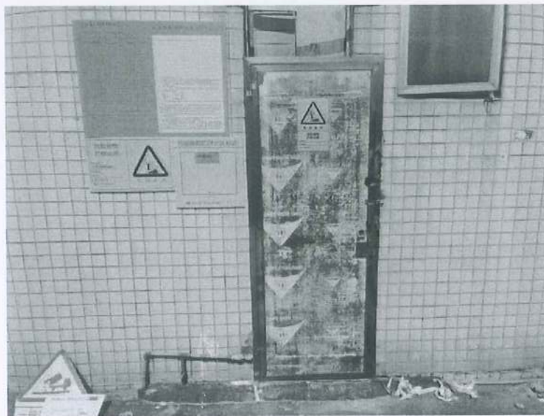
图 4.4 危废房外部图
