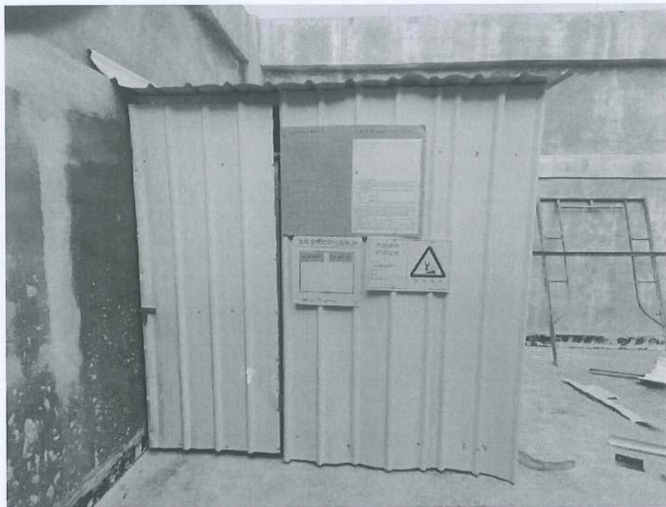
图 4.4 危废房外部图
