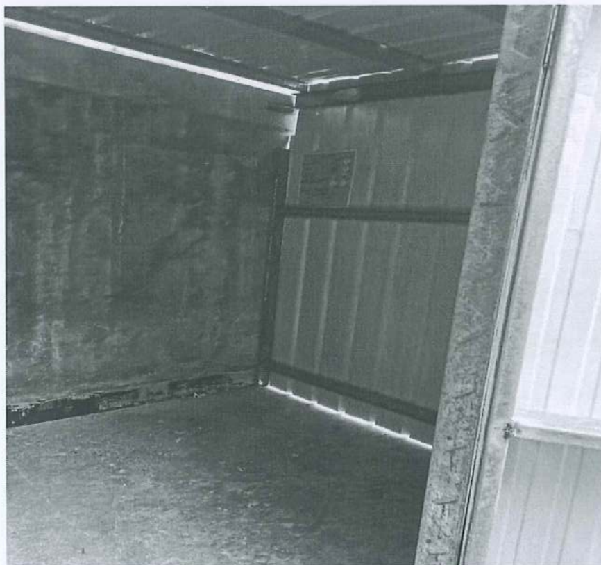
图 4.5 危废房内部图
