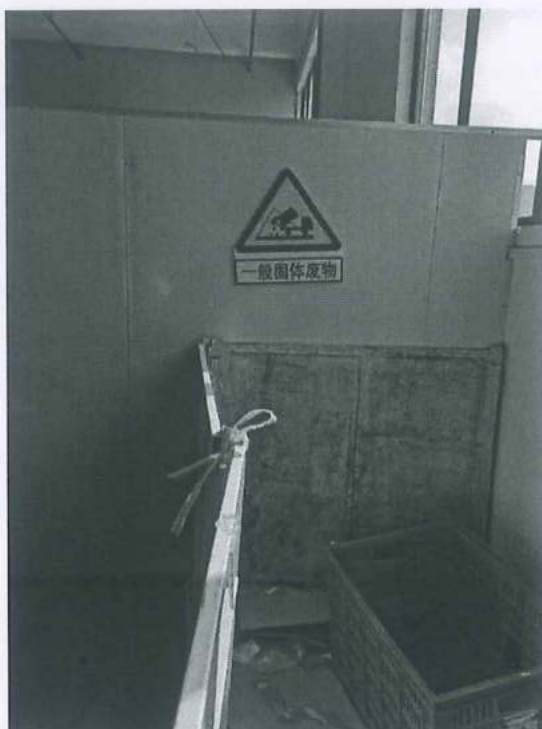
图 4-3 一般固废间现场图
