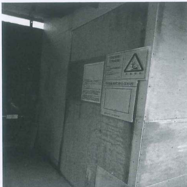
图 4-4 危废贮存仓外部图
