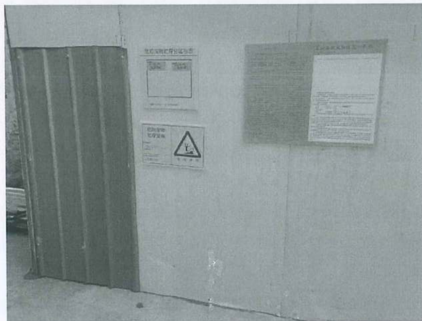
图 4.3 危废贮存仓外部图
