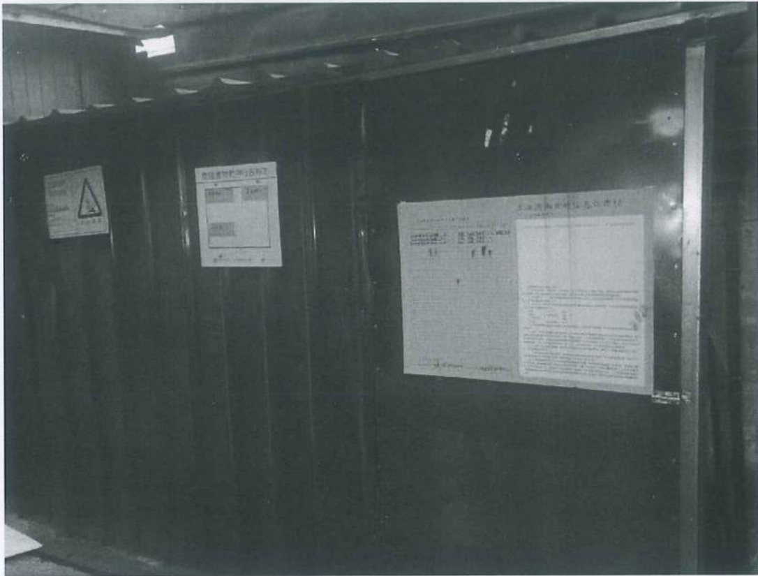
图 4.3 危废贮存仓外部图
