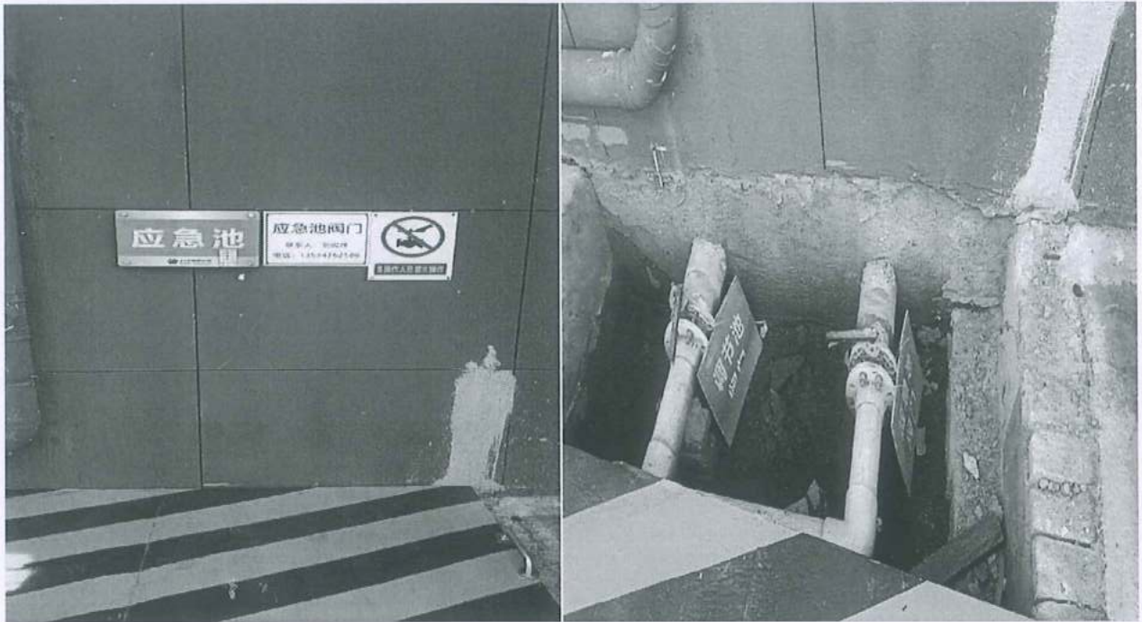
图 4-6 应急池与应急池阀门图片
