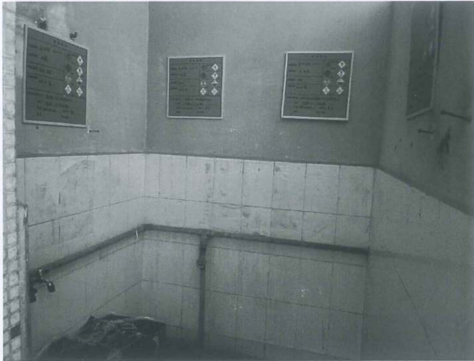
图 4-4 危废贮存仓内部图
