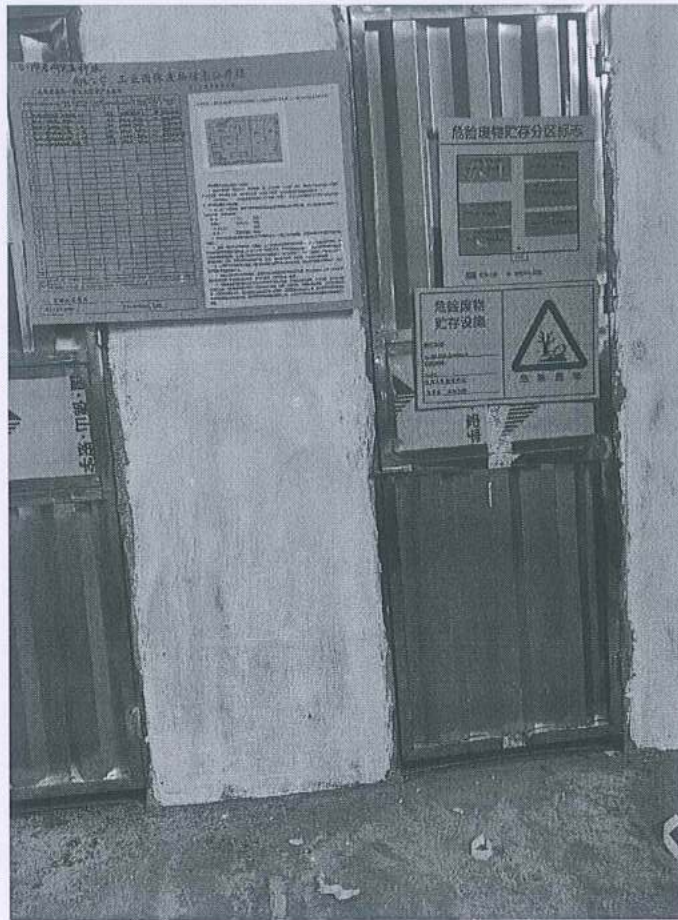
图 4.2 危废间外部图
