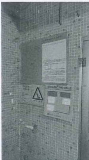
图4.2危废间外部图
