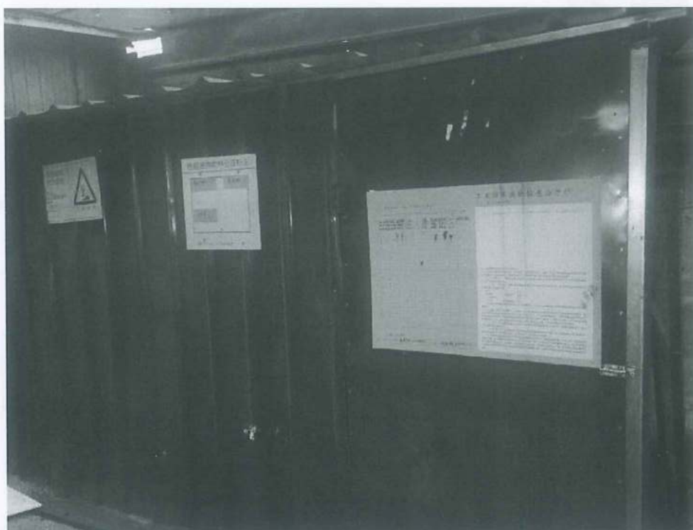
图 4.3 危废贮存仓外部图
