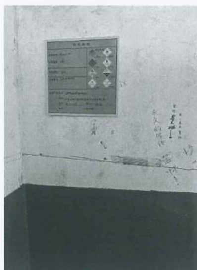
图4.3危废间内部图
