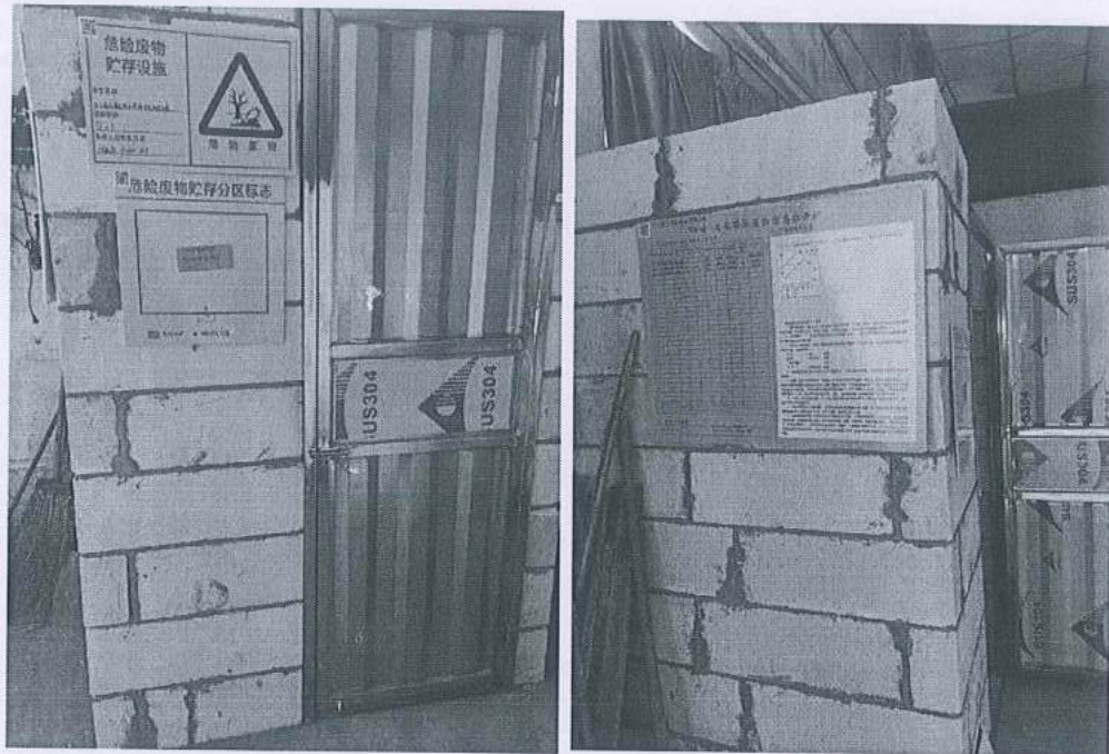
图 4.2 危废间外部图
