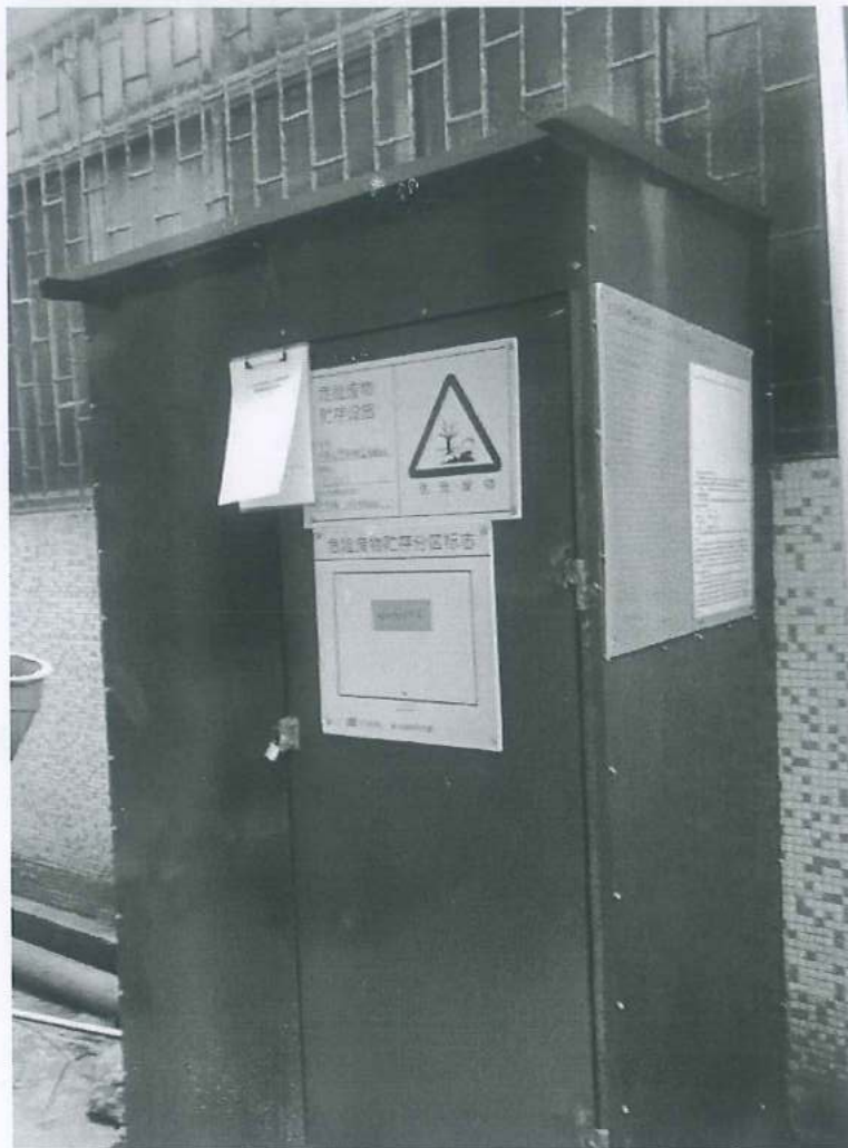
图 4.3 危废贮存仓外部图
