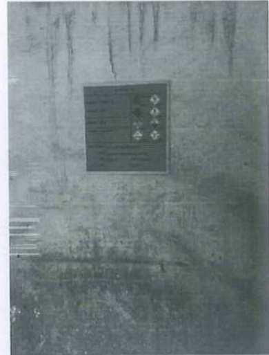
图4.3危废间内部图
