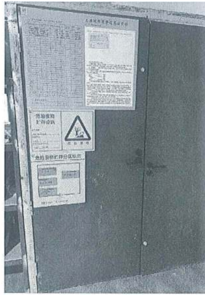
图 4.2 危废间外部图
